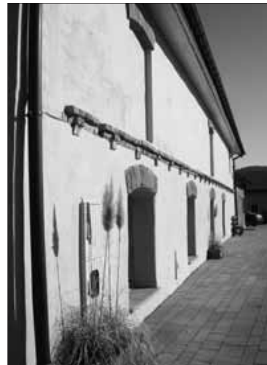
Ściana jak gdzieś w Toskanii
