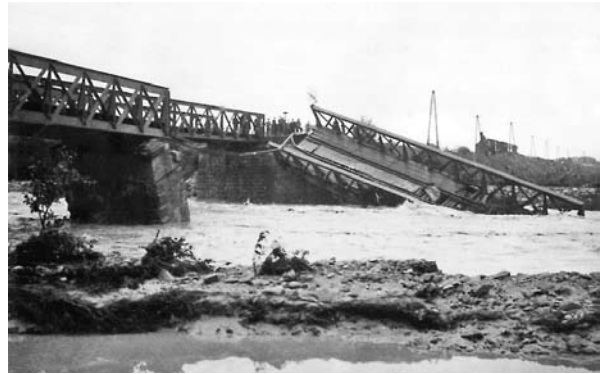
Most kolejowy na Kamienicy zerwany przez powódź w 1934 r.
