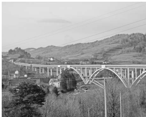
Wiadukt w Milówce
