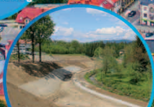
Budowa tras rowerowych
