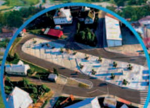
Budowa Zintegrowanego Węzła Przesiadkowego
