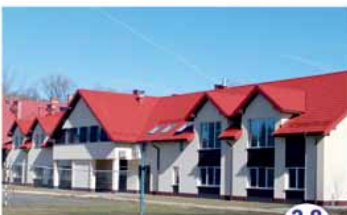
Budowa nowej części Specjalnego Ośrodka Szkolno - Wychowawczego w Dobrej
